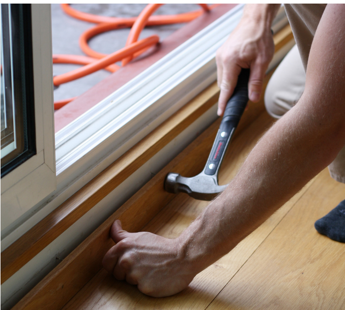
Bild 1. Utredning av fuktskada.
